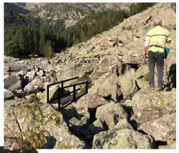
Petits ouvrages de franchissements ponctuels de structure métallique pour être le plus discret possible – possibilité de replis en hiver.
