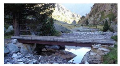
1er FRANCHISSEMENT: type passerelle bois sur IPN (passages ruisseaux => ex: passerelle basse Plaa du Larribet, PNP) ou pont sur câble: dans les deux cas réalisation de culées béton avec habillage pierre pour intégration et ouvrage court et bas pour respecter la séquence paysagère.
