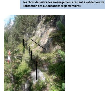
Analysé dans la proposition : association de main courante rigide pour le confort et de garde corps pour la sécurité
